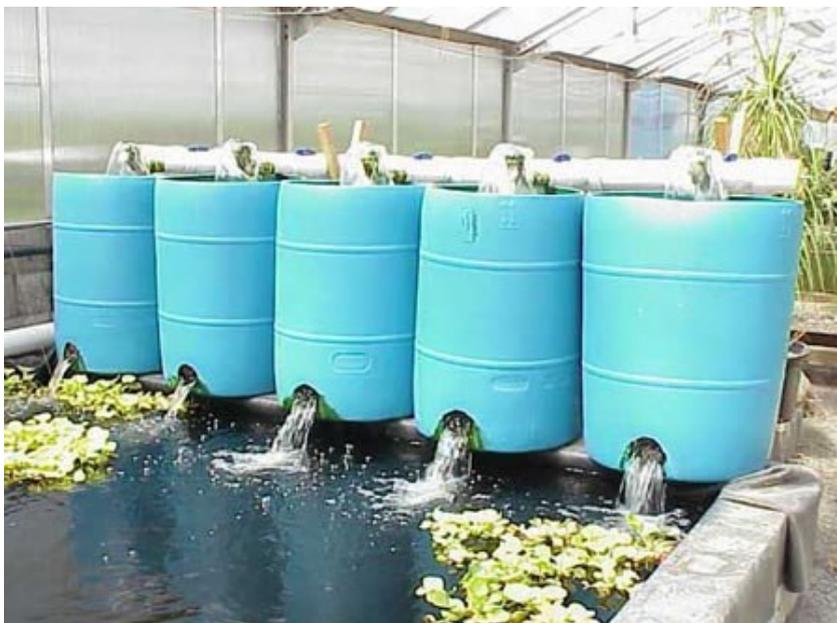
BATTERIE DE BIO-FILTRES POUR LE TRAITEMENT D'UNE EAU USÉE ET LA FILTRATION SIMULTANÉE DES MATIÈRES SOLIDES.
